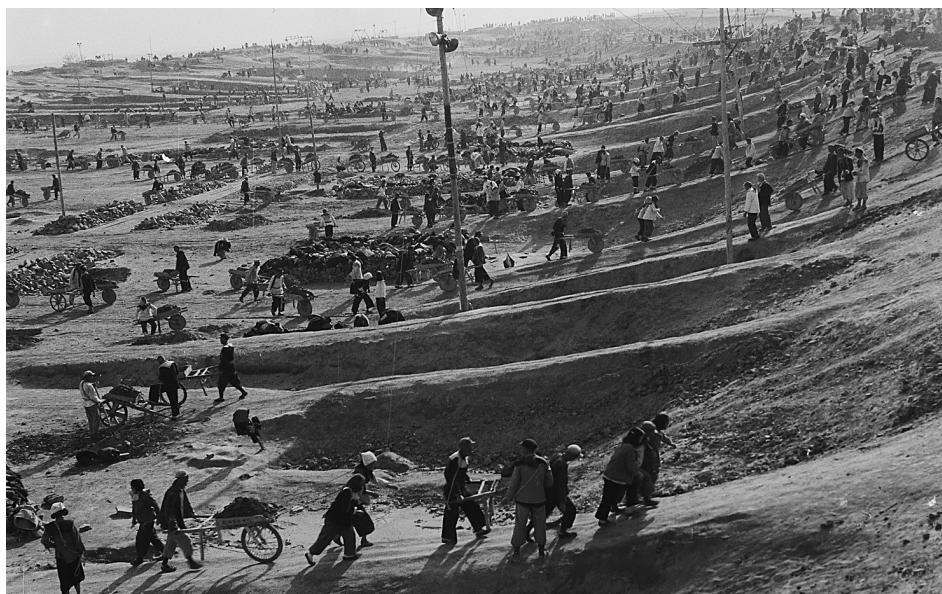
水库大坝施工现场 李德武 摄
