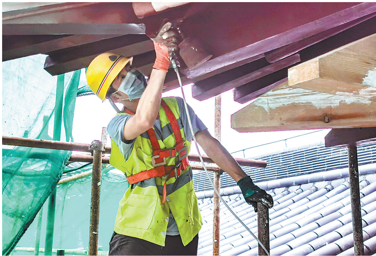
9月3日上午,在鲁山县花瓷古镇项目建设工地,工人在对门楼进行喷漆作业。
