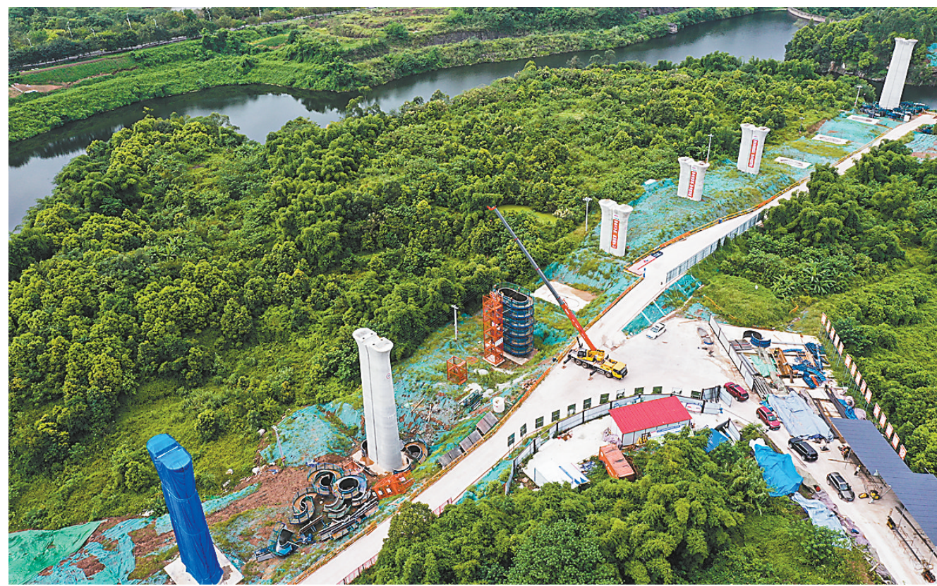
渝昆高铁川渝段加紧施工
