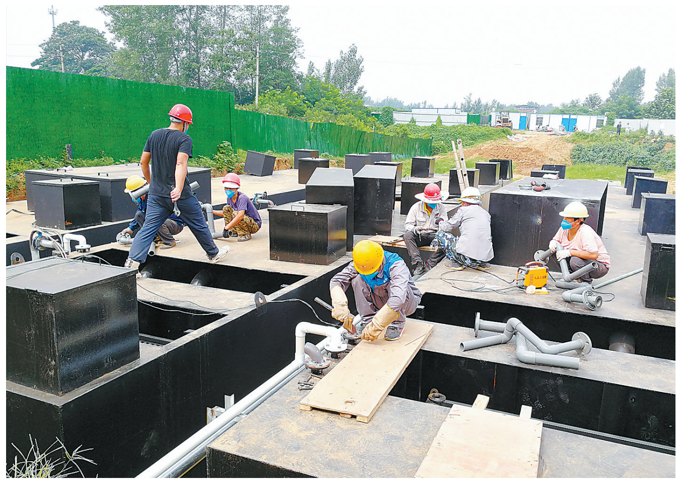
安装一体化污水处理设备
