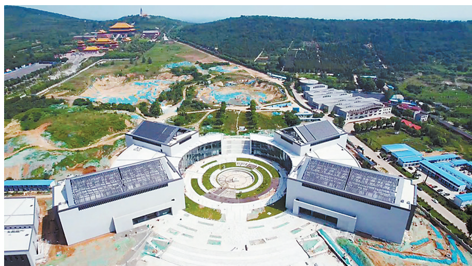
建设中的市树雕艺术博物馆项目(无人机拍摄)
