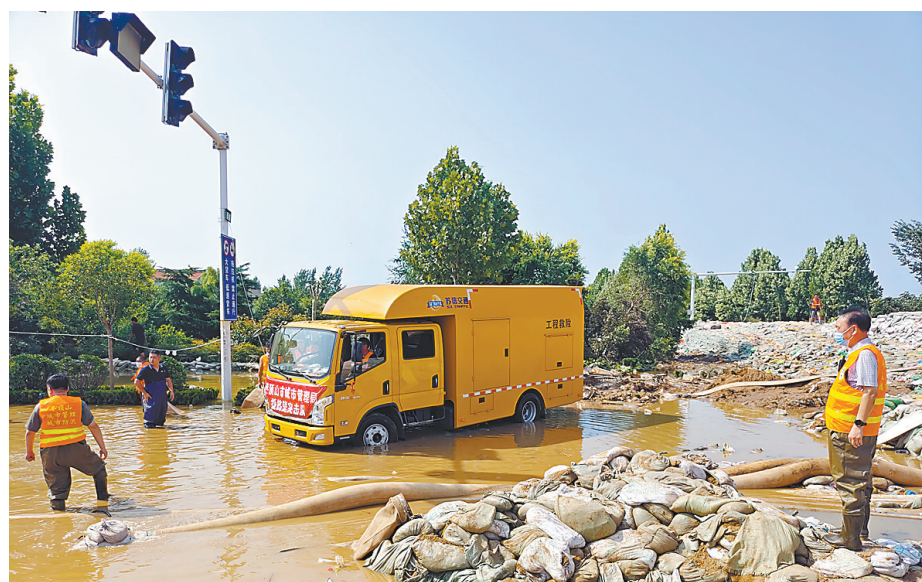
8月2日,救援队员抽排堤内涌入的洪水。
