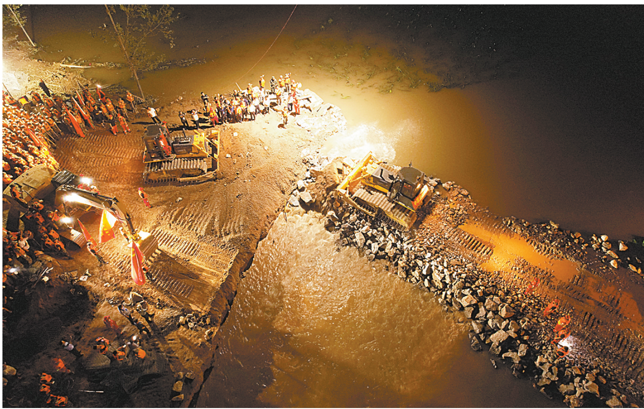
这是七月二十六日拍摄的卫河鹤壁市浚县新镇镇彭村决口封堵现场(无人机照片)。新华社发
