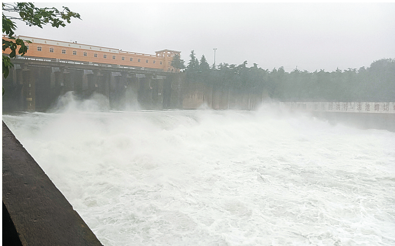
7月20日,水流自白龟山水库闸门处喷涌而出,激起层层水雾。
