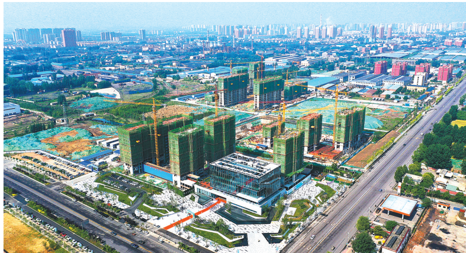
建设中的平顶山国际物流产业新城
