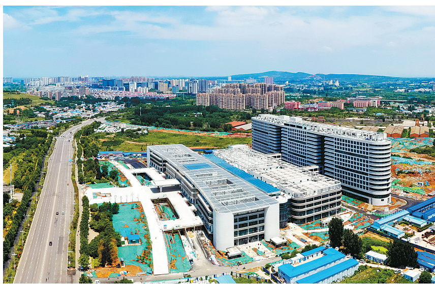
示范区未来路的市第一人民医院新院区(含市儿童医院)项目工地
