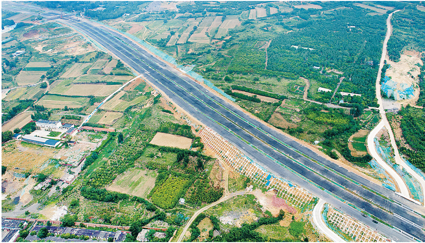
航拍正在建设中的鹰城大道
