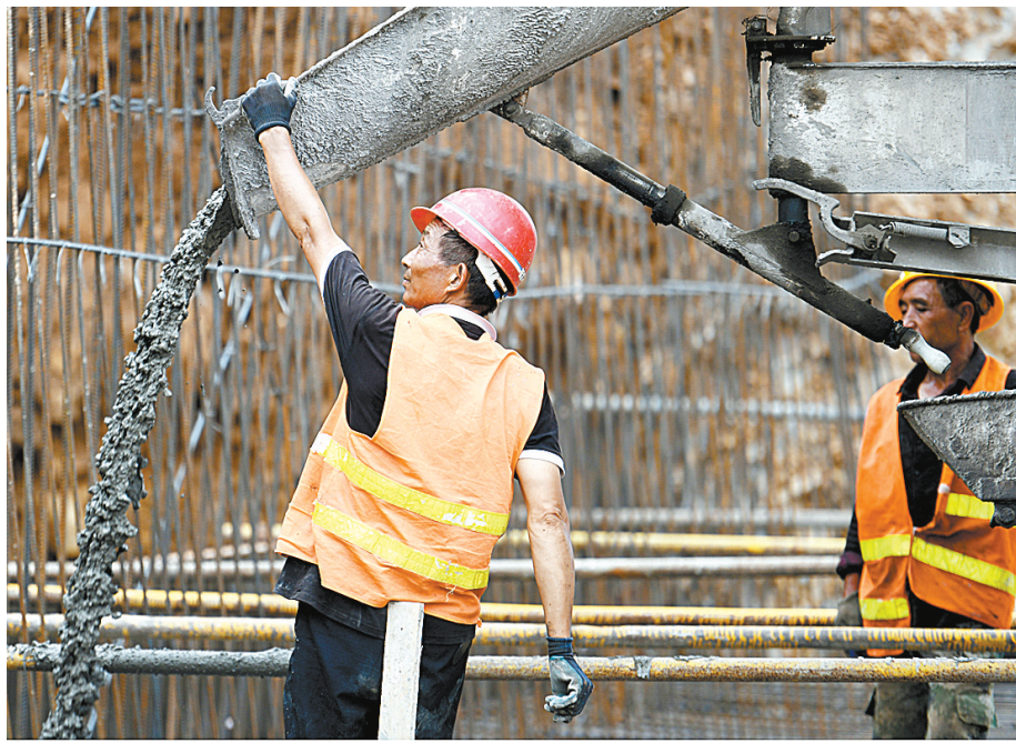
工人正在浇灌混凝土
