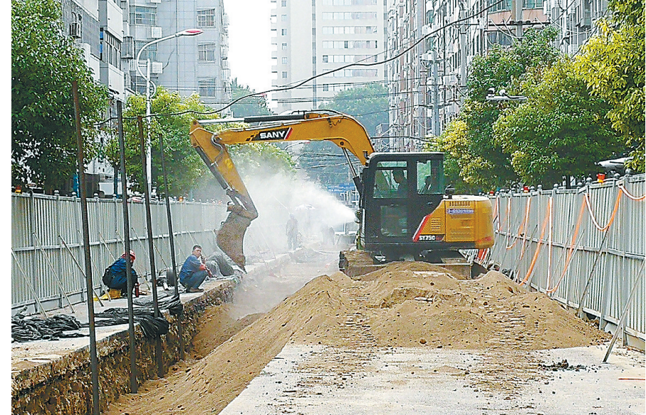
加快管网改造 6月29日,施工人员在市区曙光街中段回填供热管道沟槽。为加快完善我市供热管网系统,切实提高供热系统安全性和用户供热品质,平顶山热力集团有限公司自5月开始,分标段对曙光街一侧的供热管道进行改造,预计此处管网改造工程于9月下旬结束。 本报记者 姜涛 摄
