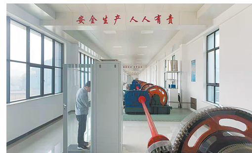
工作人员在大坝启闭机房认真进行例行值班检查。杨德坤 摄
