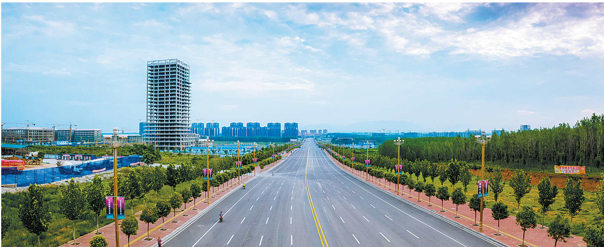
温泉镇加快镇区道路等基础设施建设
