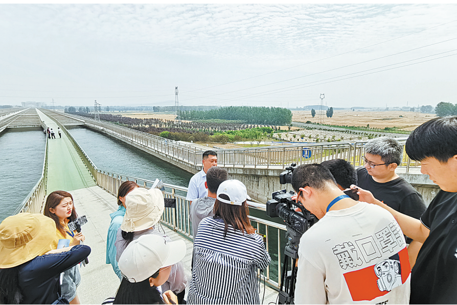
记者在水北调中线沙河渡槽采访
