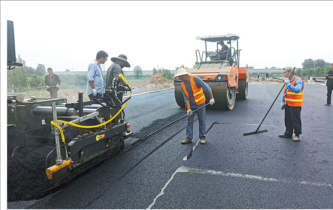
▲铺设路面沥青混凝土
