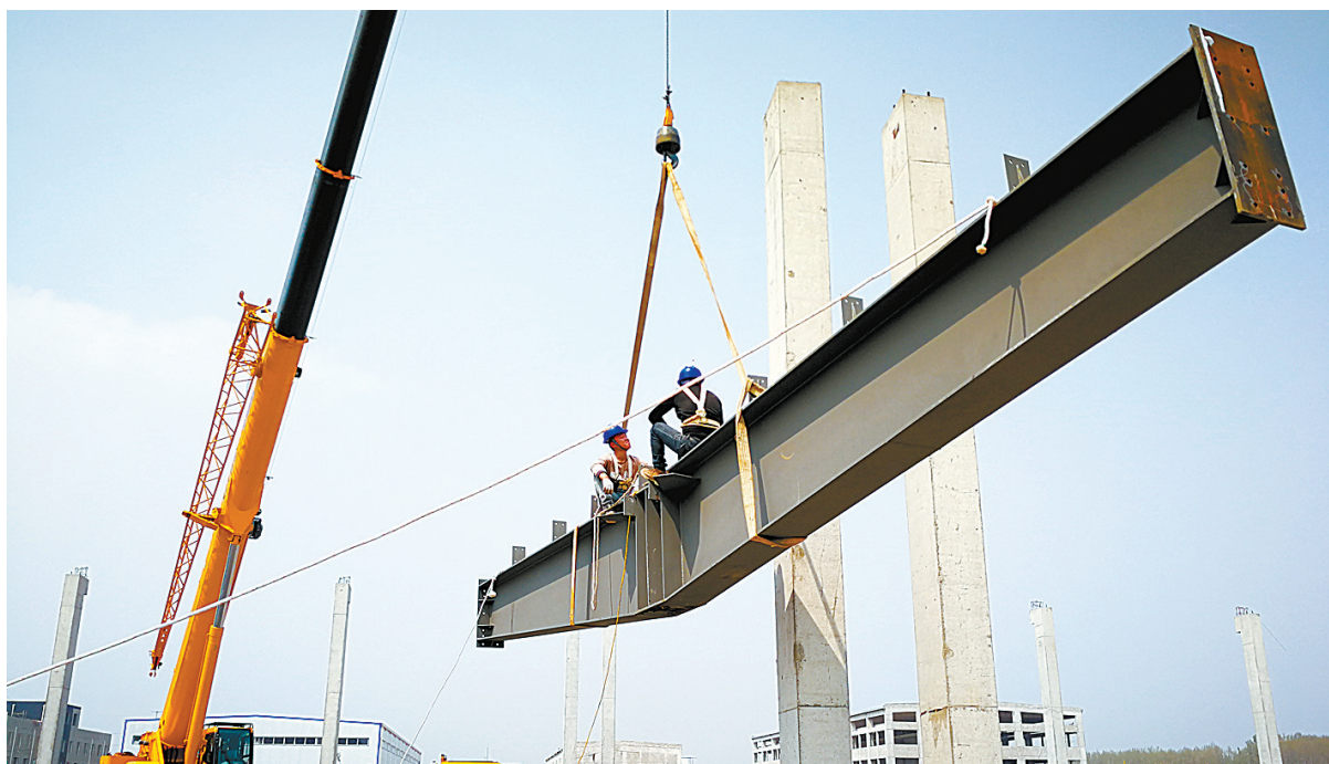
4月8日,施工人员在平顶山织造产业园标准化厂房(A)项目施工现场吊装厂房屋架梁。该项目位于尼龙新材料产业集聚区,占地60.88亩,主要建设制造车间、研发楼、消防泵房等建筑,以及厂
