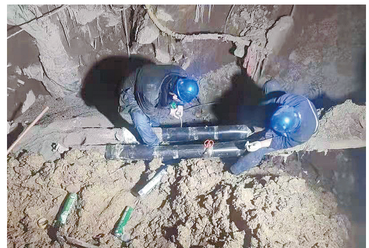
市热力公司的工作人员在修补管道。长青社区供图
