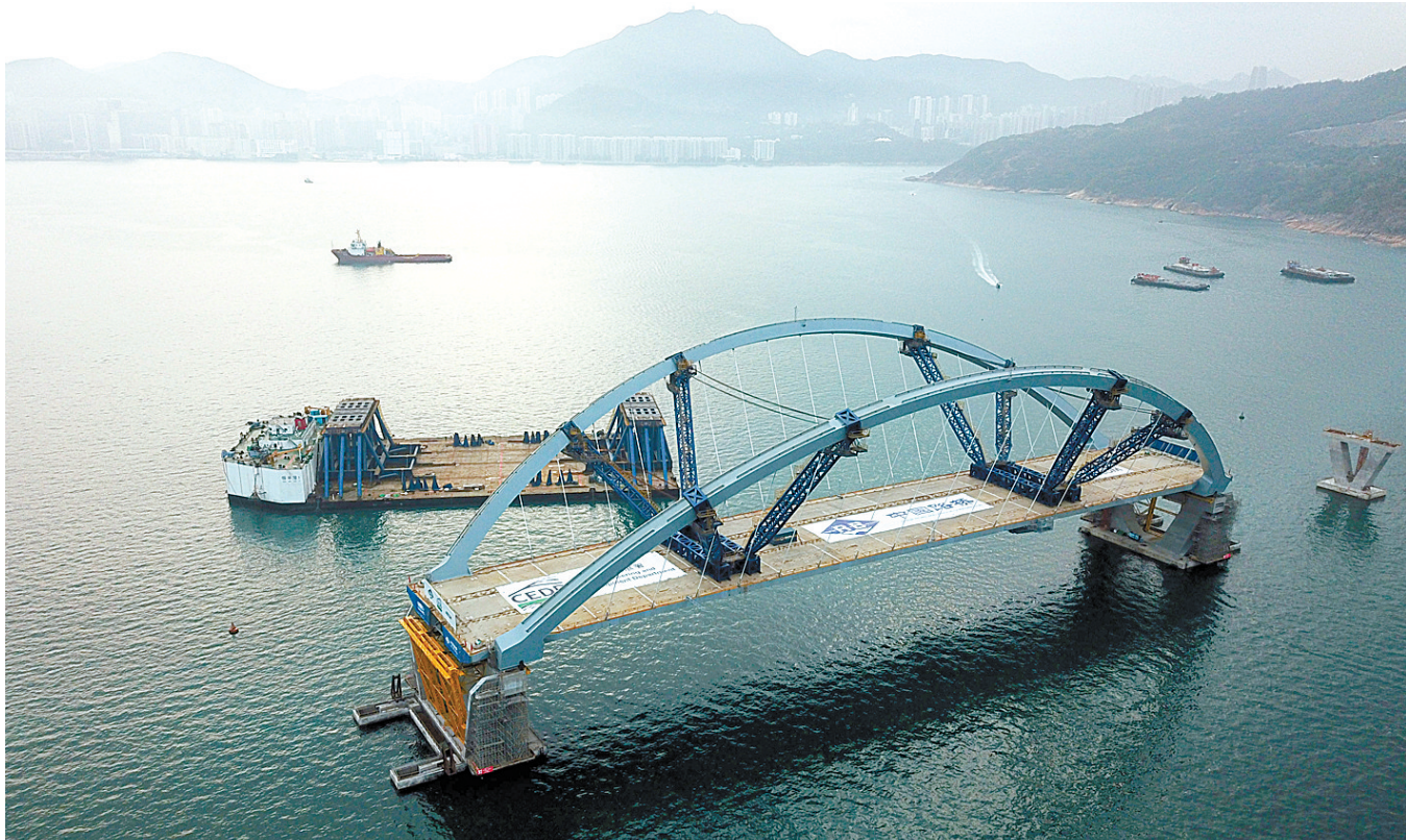
内地企业独家承建的香港将军澳大桥主桥安装成功
