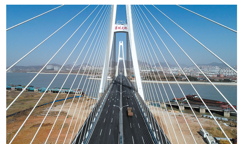
安徽巢湖大桥建成通车 1月12日，车辆行驶在巢湖大桥上（无人机照片）。当日，由中铁建大桥局承建的安徽巢湖大桥建成通车。巢湖大桥桥设计为全线双向六车道，桥梁长度1122米，于2018年1月12日正式开工建设，是环巢湖大道贯通的重要节点工程之一。 新华社发
