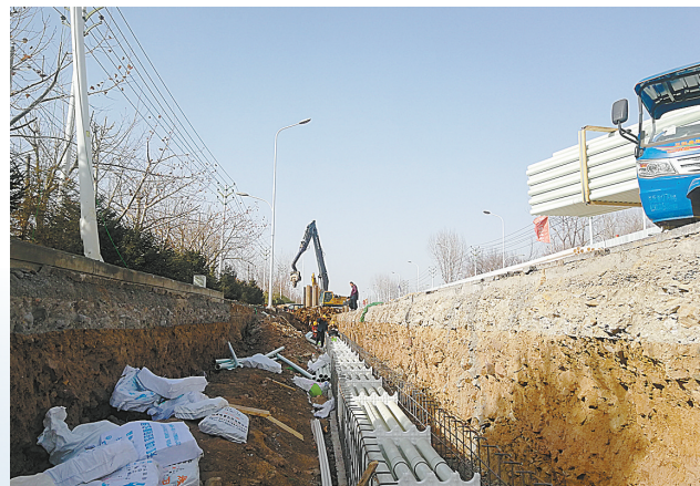
舞钢市政管网加紧施工
