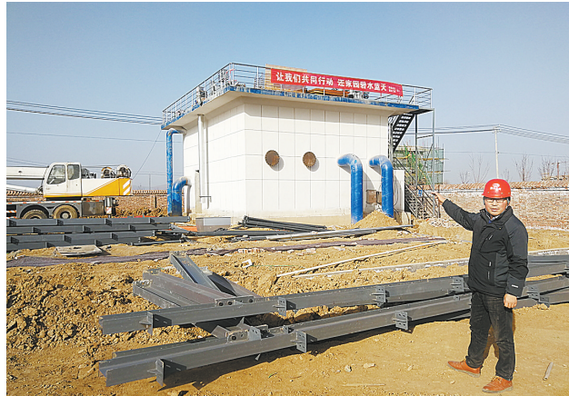
格栅配水井完工
