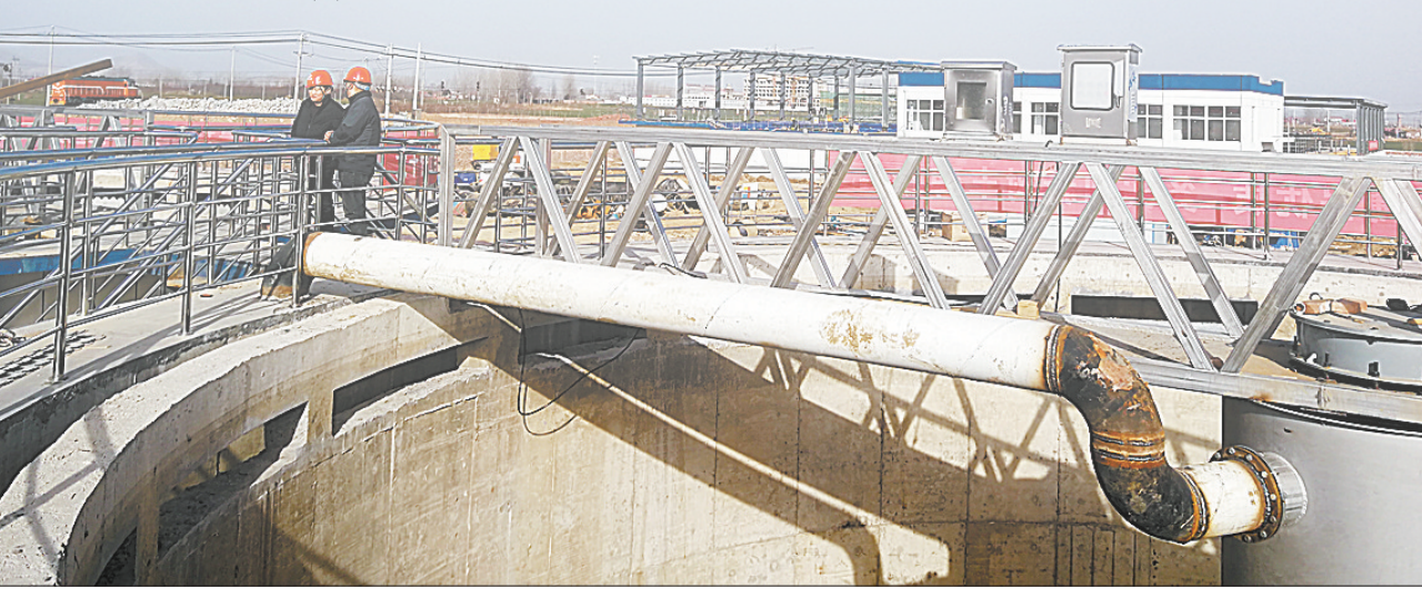
▼污泥沉淀池具备运作条件
