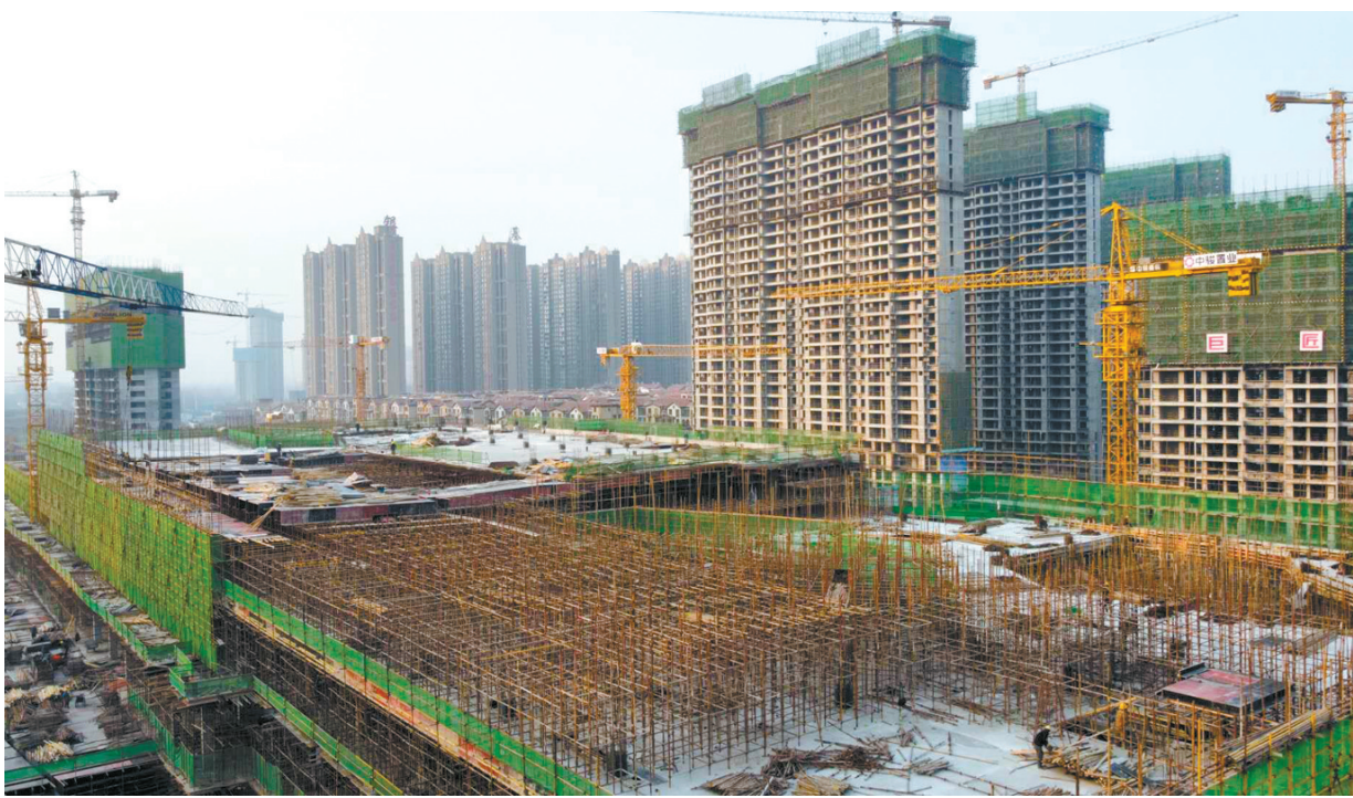
推进项目建设
