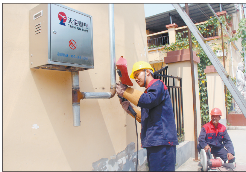
安装天然气管道
