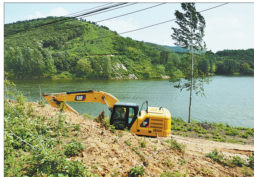
修建旅游扶贫线路
