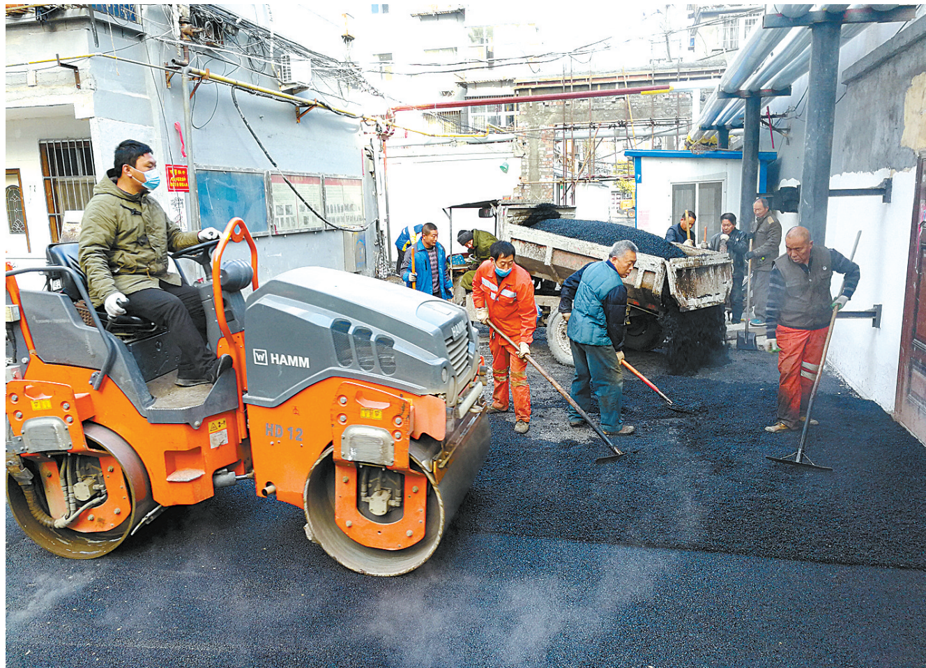
改造老旧小区
