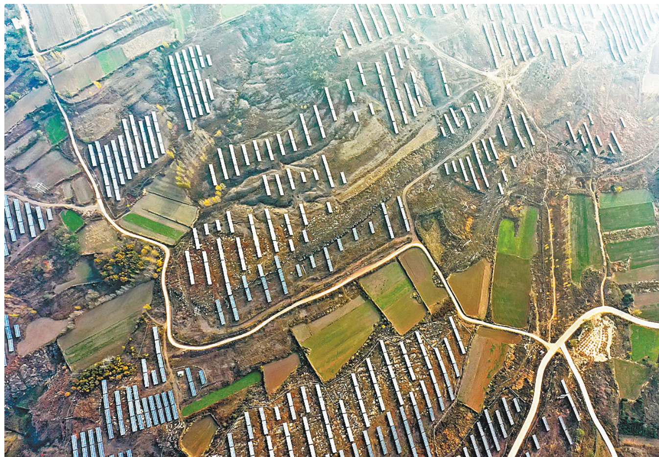
图为11月13日无人机拍摄的宝丰县观音堂林站山坡上的光伏项目。
