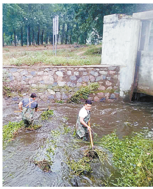
疏浚河道 杨德坤 摄
