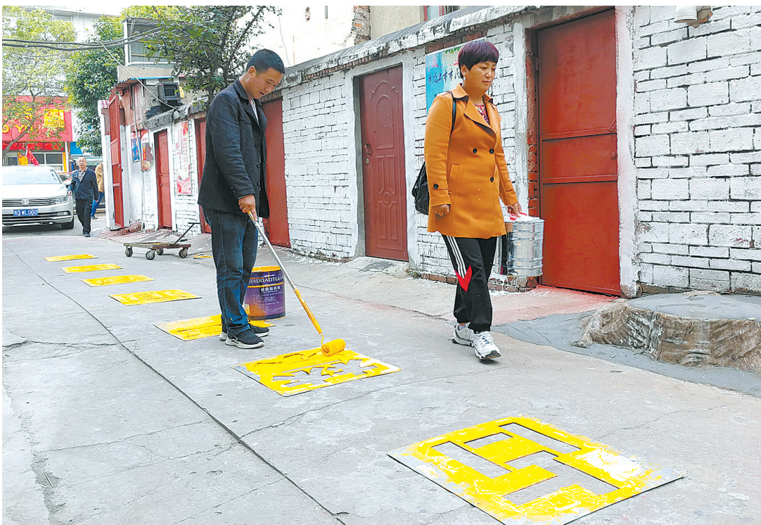
规划消防通道 10月12日,施工人员在新华区湛北路街道朝阳社区的一个院落施画消防通道标识。为进一步规范停车秩序,朝阳社区组织工人对辖区院落停车位及消防通道进行了规划。 本报记者 姜涛 摄
