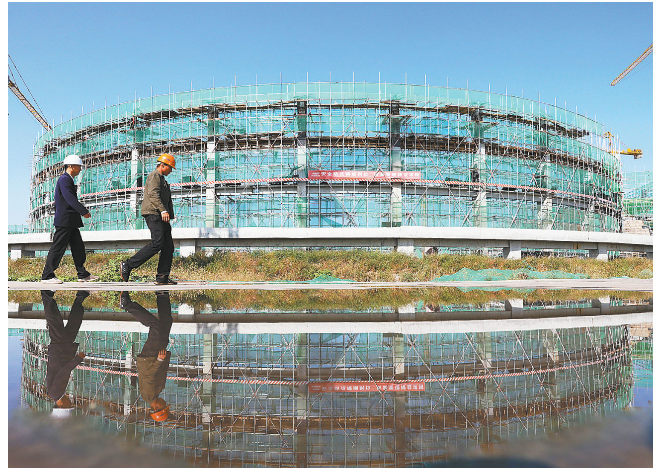
张家口：奥体中心建设有序推进
