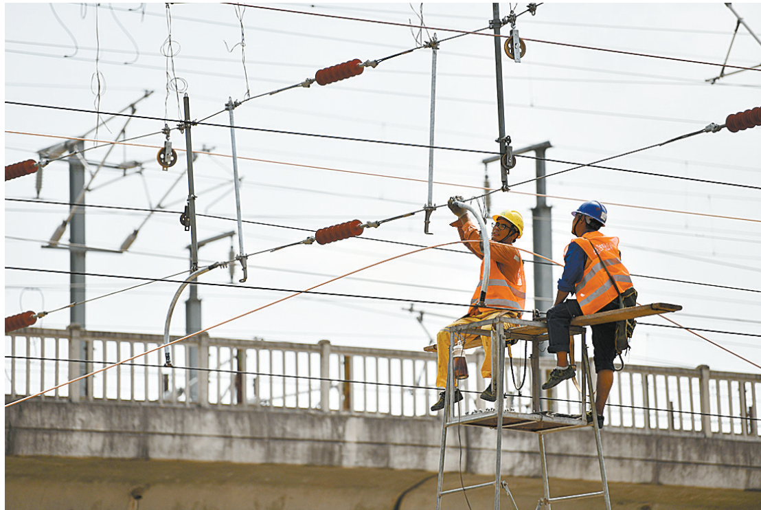
铁路建设施工忙 近日,由中铁四局电气化公司施工人员在双墩集站站改施工现场作业。
