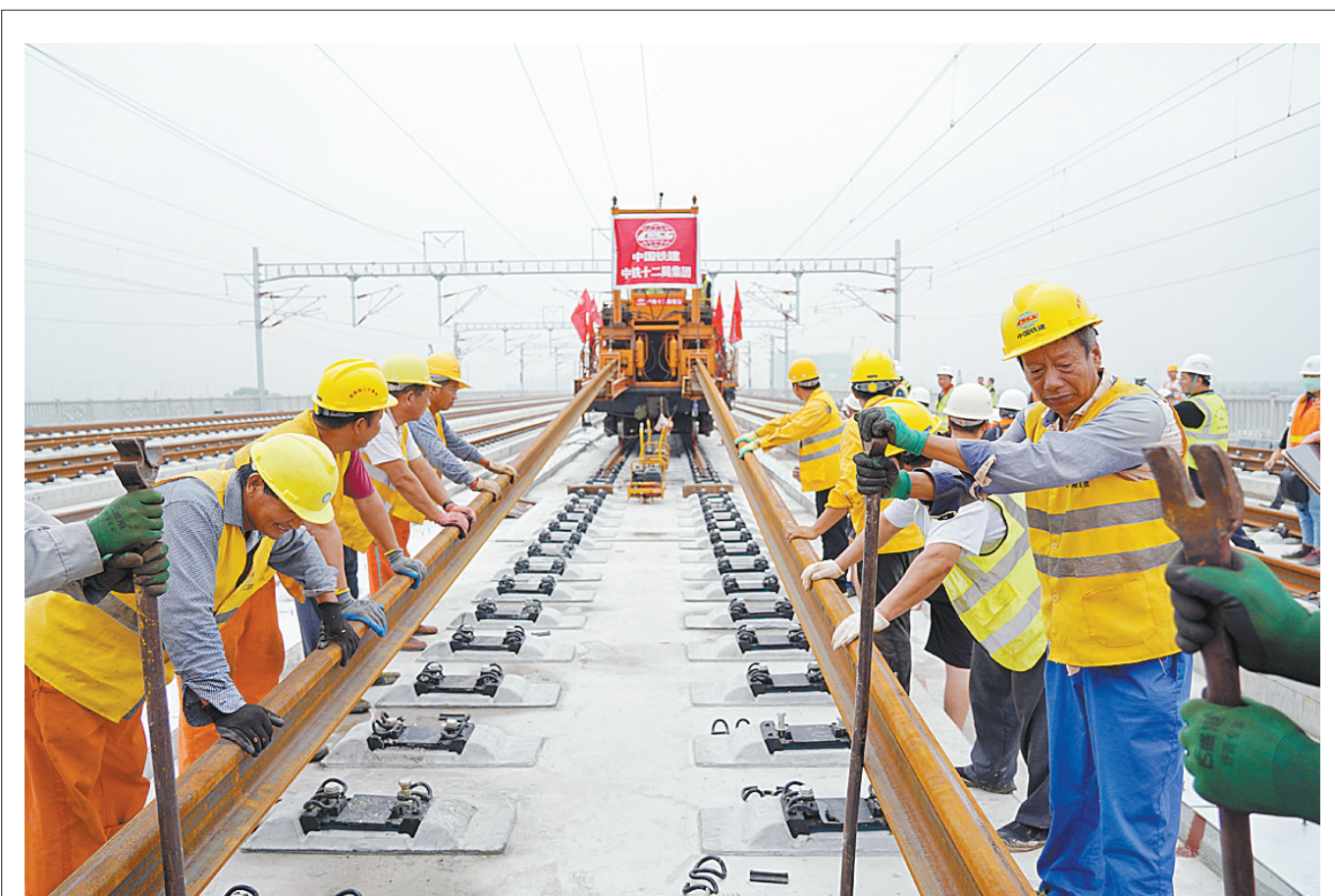
8月17日,中铁十二局工人在进行铺轨作业。
