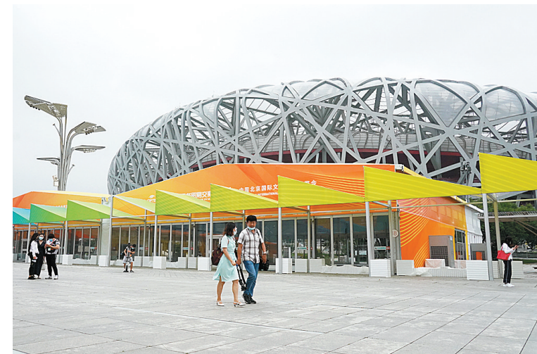
2020服贸会室外临时场馆搭建完成
