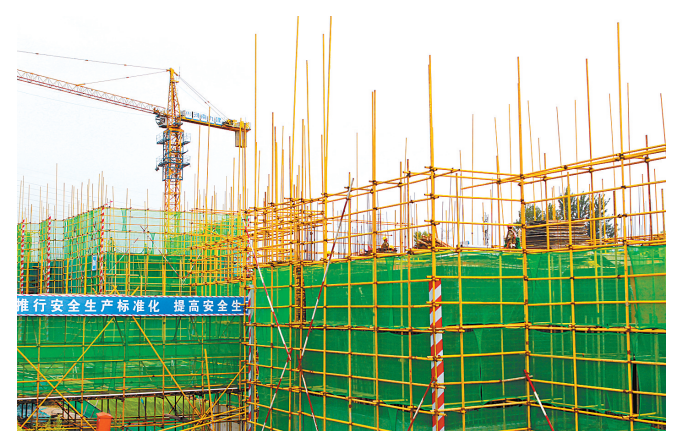
加紧建设采煤陷区综合治理项目
