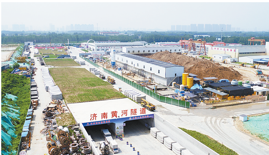
“万里黄河第一隧”已掘进至黄河主河槽
