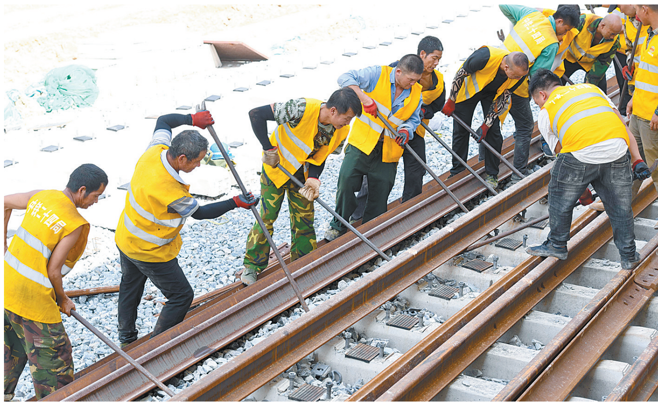
福平铁路全线铺轨贯通
