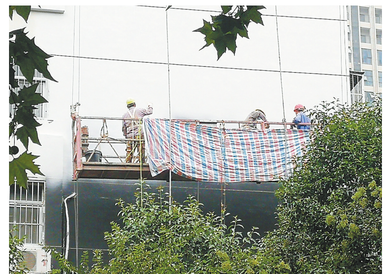
粉刷楼体外墙
