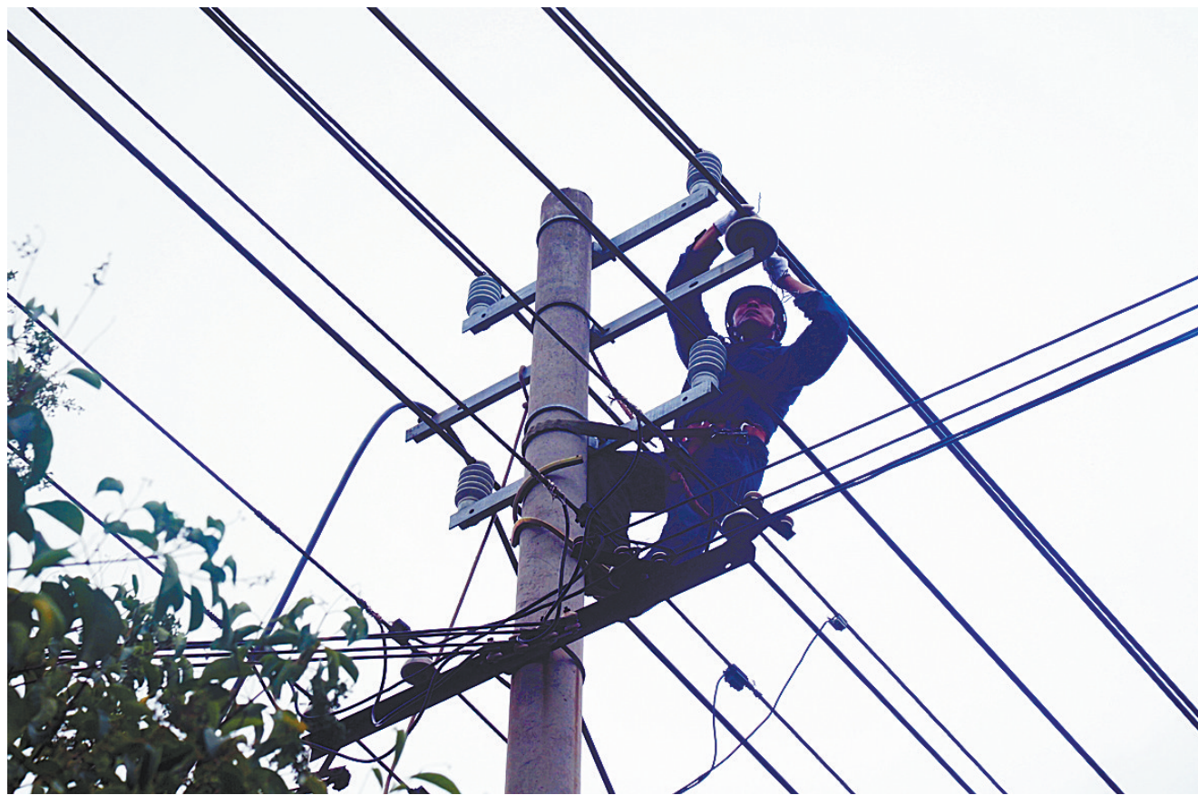
紧急抢修保供电
