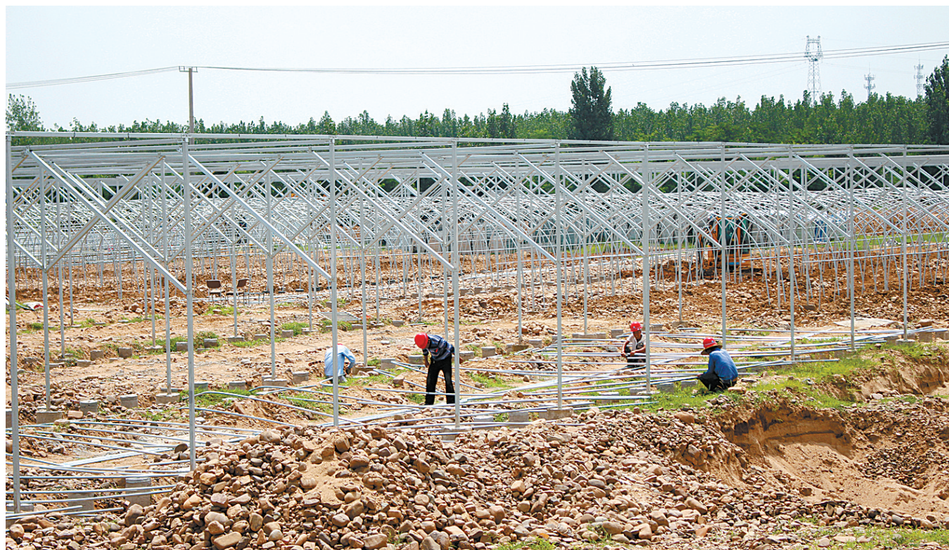
7月16日，在马楼乡虎营村香菇生产基地，施工人员在搭建香菇种植大棚。该项目位于虎营村北、沙河河南岸，项目一期占地230亩，总投资2700万元，今年5月开工建设，计划8月底竣工。项目建成投产后，可提供就业岗位300余个。李东旭 摄
