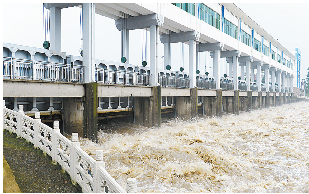
王家门坝开闸泄洪,淮河水位快速上涨。
