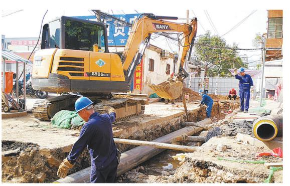
烈日下施工忙 7月20日,施工人员在市区联盟路西段(光明路至迎宾路)热力管道进行改造,为解决联盟路西段两侧部分群众冬季取暖问题,市热力公司于
