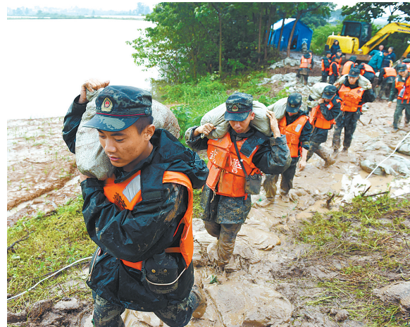
安徽和县:加固河堤保安全
