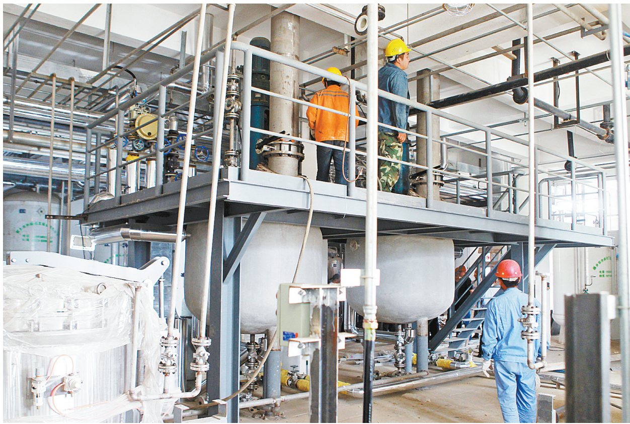
加紧安装调试设备
