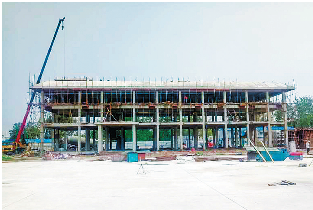
建设新公交枢纽站
