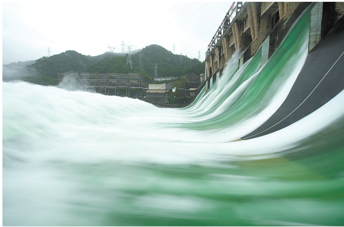
新安江水库开启7孔泄洪
