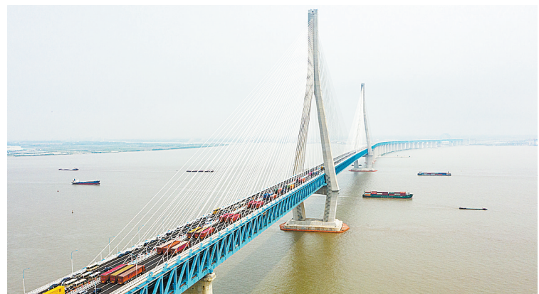
沪苏通长江公铁大桥正式开通运营
