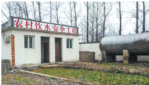
无塔供水设施和管网延伸覆盖工程是村里的第三、四代饮水工程(资料图片)
