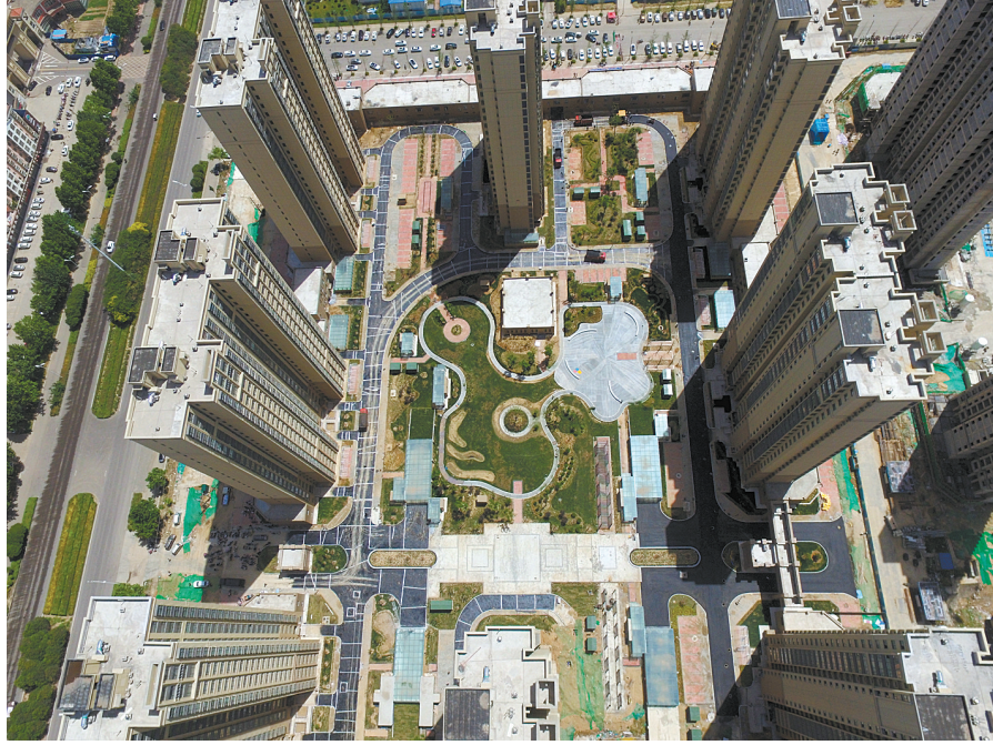
市重点项目、中建七局高新区湛南棚户区改造项目一期实现交房,二期正在加紧建设中(无人机图片) 鲁大辉 摄
