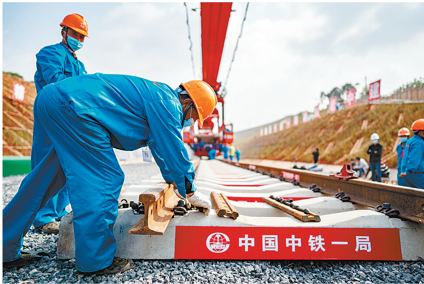
新老铁路国内段开始铺轨
