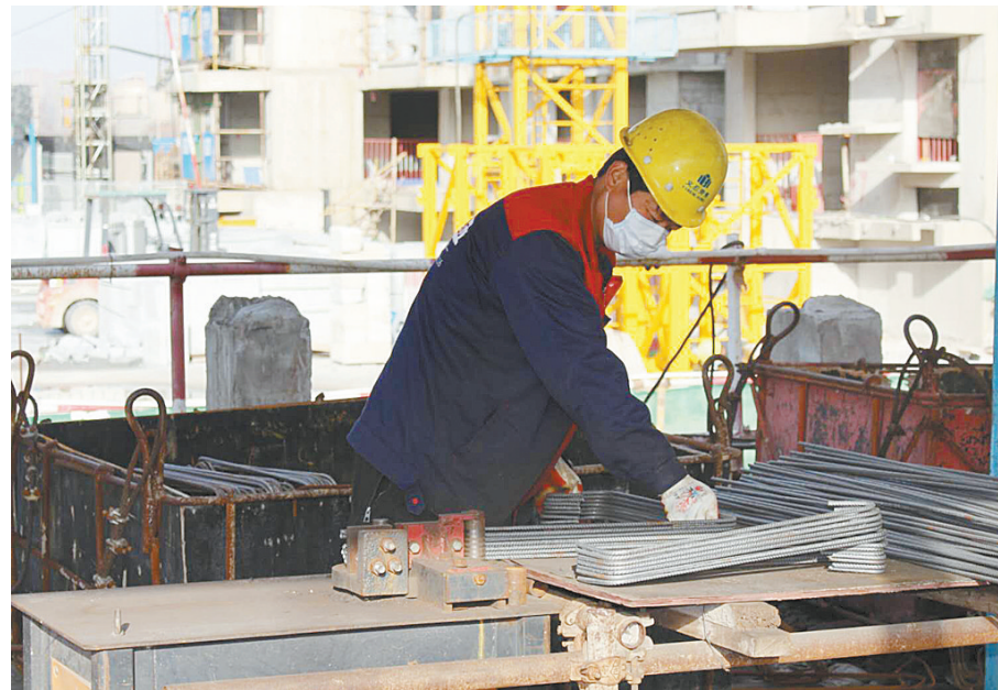
3月10日,市重点工程——高新区湛南项目二期建设现场工人在绑扎钢筋。 鲁大辉 摄
