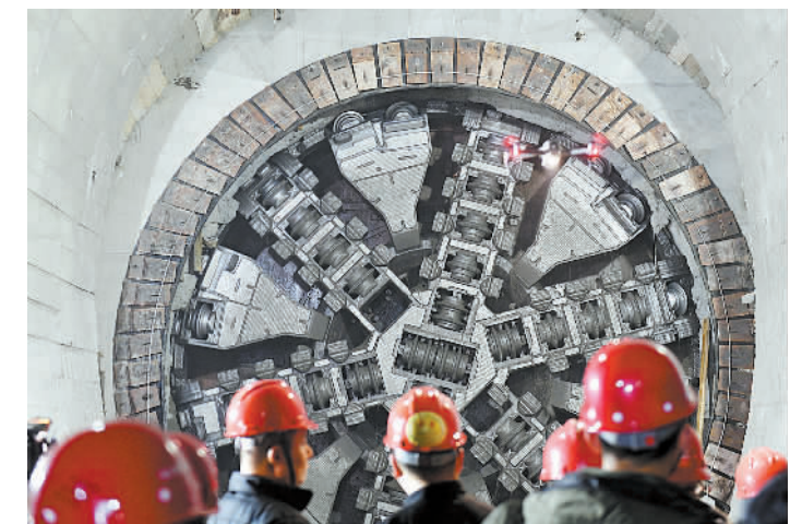
我国穿越海底距离最长地铁隧道贯通
