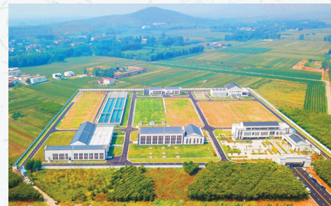
南水北调平顶山焦庄水厂鸟瞰图
