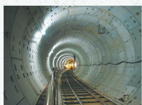
施工中的郑州地铁隧道
