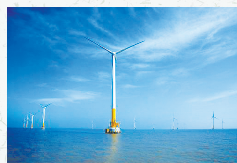
承建的海上风电桩基工程
