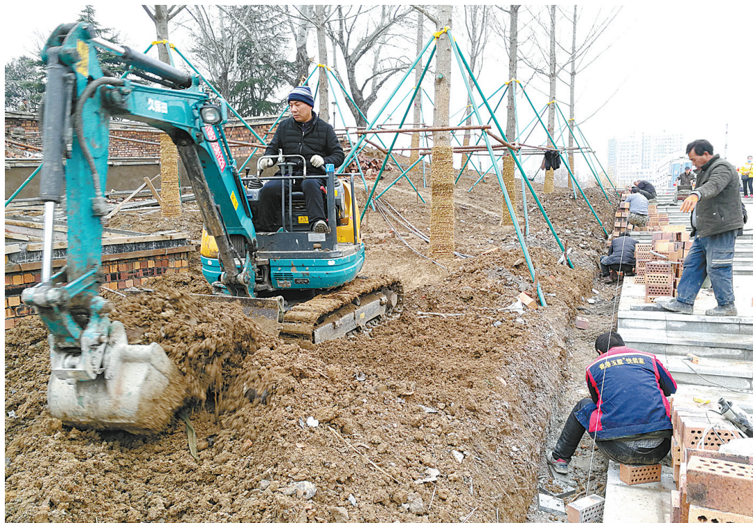
湛河公园提档升级工程有序施工
