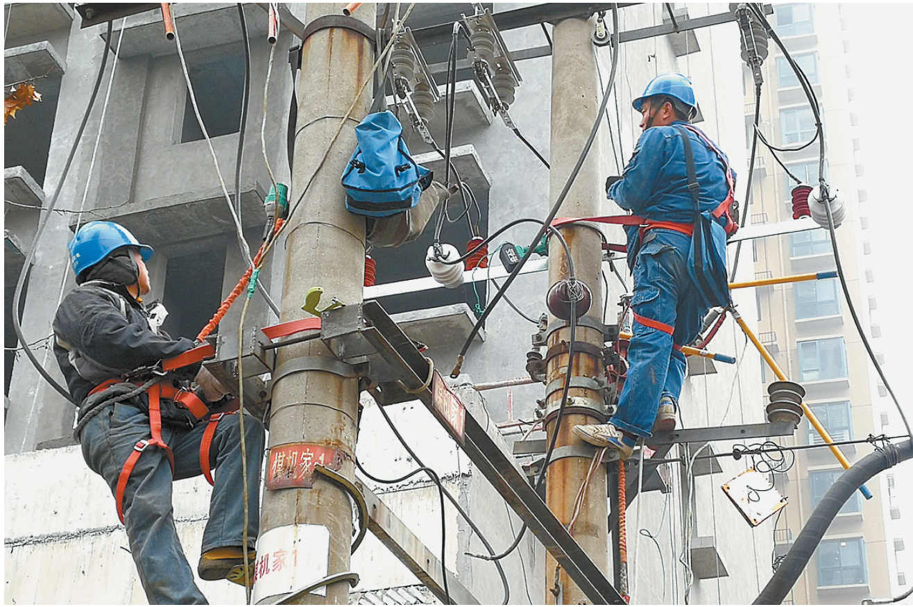
12月23日,国家电网平顶山供电公司的员工在市区和顺路路段更换断路器开关。随着气温的降低,供电线路负荷
